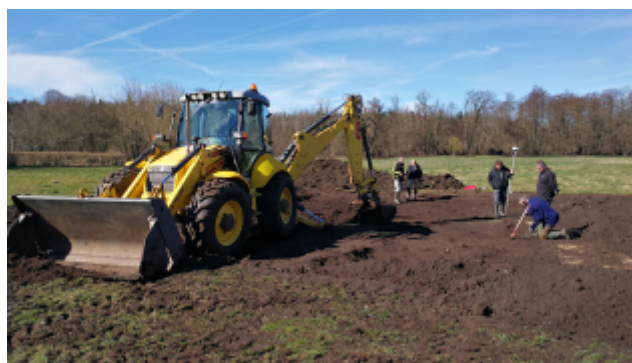
Fig. 5. Oversigt over fundspreddingen. GPS-opmåling: Villy Nielsen.
